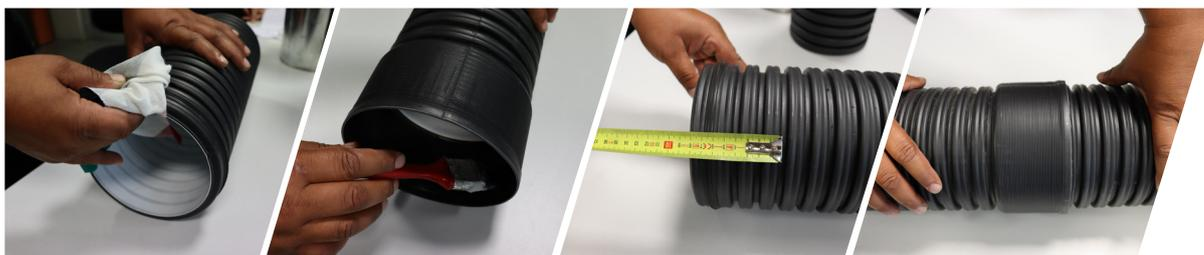
A continuación, se muestra un diagrama de montaje para tuberías de pequeño diámetro.
